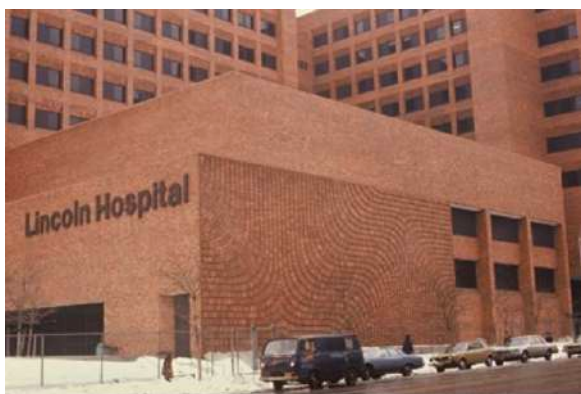
Réalisation de l'habillage en mur de brique du Lincoln Hospital, Bronx, New York. Max O Urban Architect. 1973
