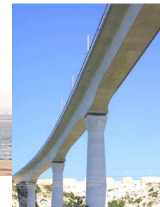
1998 Viaduc ligne TGV Avignon (F)
