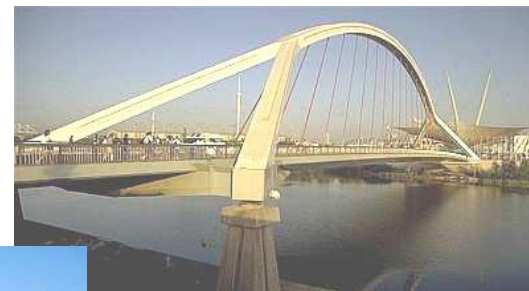
1992 Pont de la Barqueta, Séville (SP)
