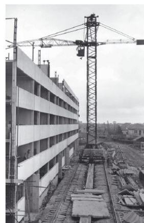
Chemin de grue (© Immobilière 3F)
