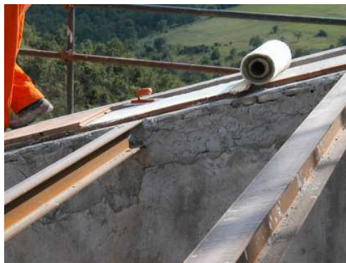
Figura 1-2 - Esempi di realizzazione
