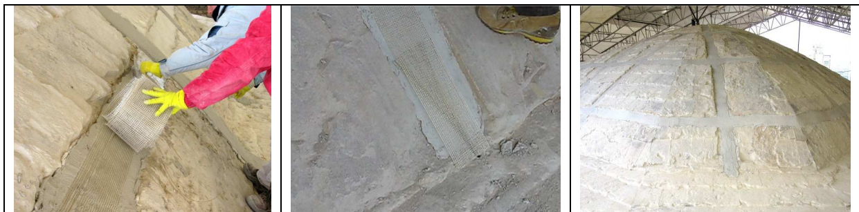
Fasi di rinforzo mediante barre in tessuto d'acciaio e malta di calce idraulica naturale
