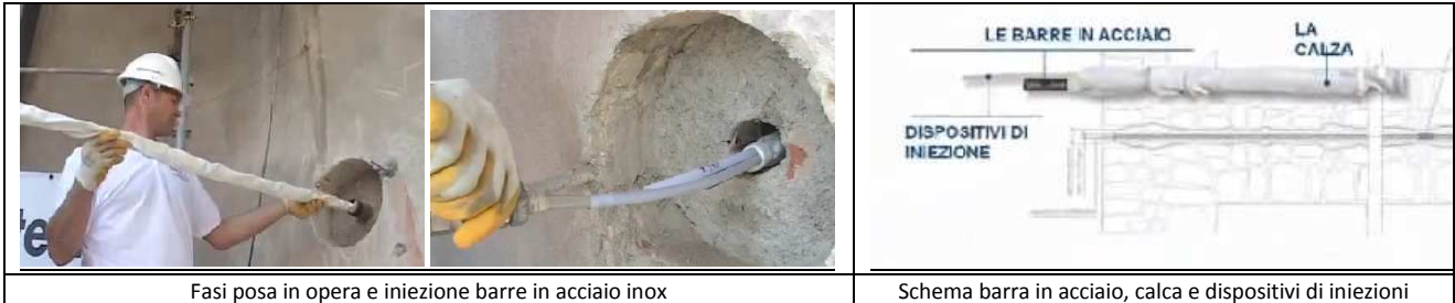
Fasi posa in opera e iniezione barre in acciaio inox
