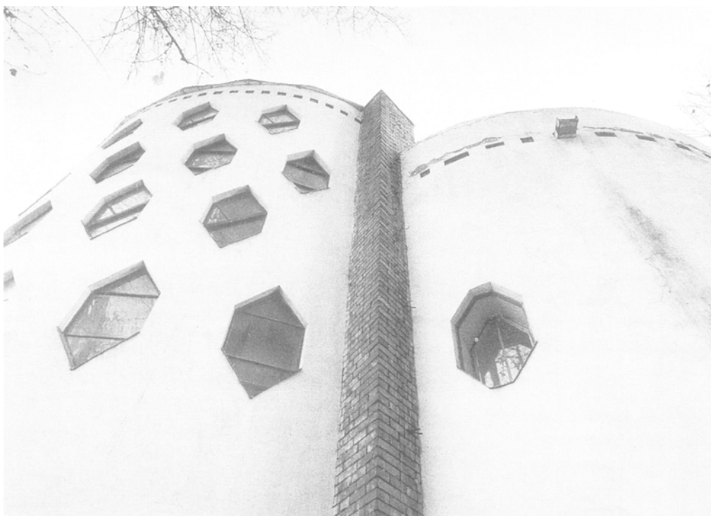
Figura 50. K. Mel'nikov, Casa Cilindrica, vista dal basso della facciata
