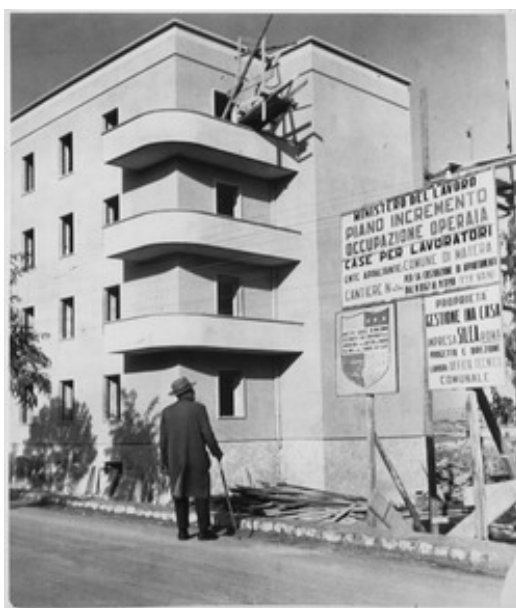
Figura 5. Cantiere di un edificio per appartamenti del quartiere INA - Casa a Tiburtino
