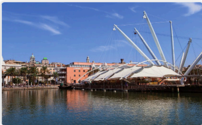
▲ Questa tensostruttura fa parte delle opere di riqualificazione del Porto Vecchio di Genova, progettate da Renzo Piano.
