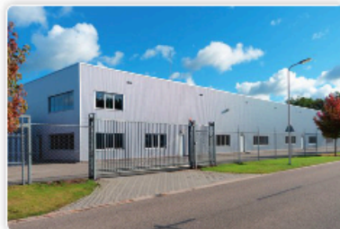
▲ Capannone industriale prefabbricato.
