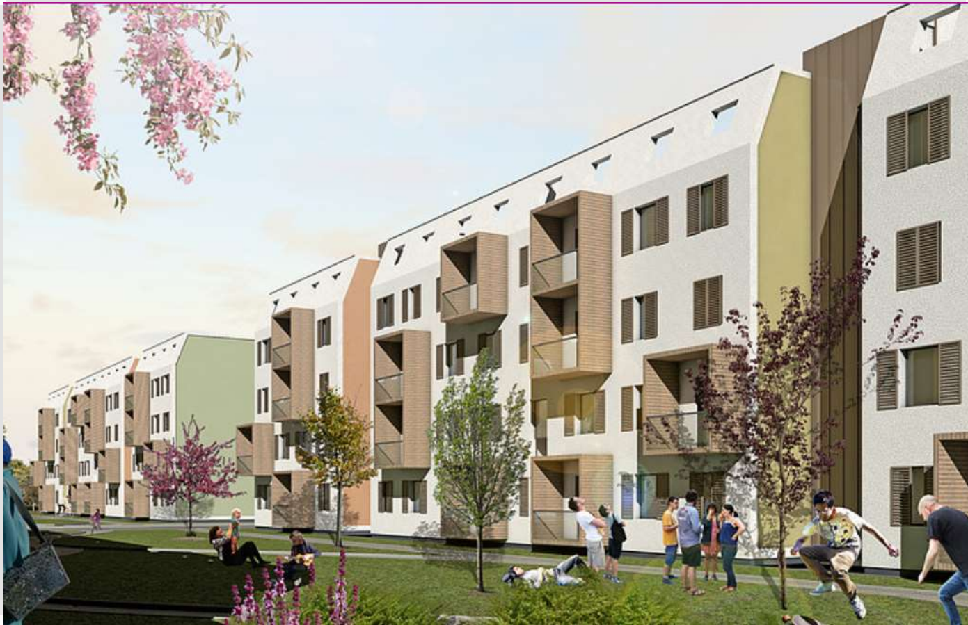
COMPLESSO RESIDENZIALE San Pietroburgo, Otpaahoe -Studio Novelli
