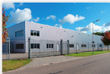
▲ Capannone industriale prefabbricato.
