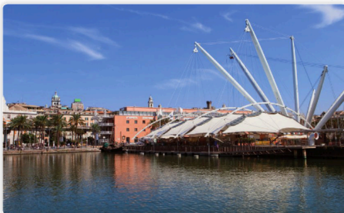
▲ Questa tensostruttura fa parte delle opere di riqualificazione del Porto Vecchio di Genova, progettate da Renzo Piano.
