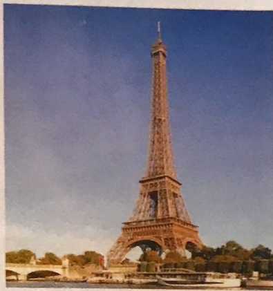
La tour Eiffel est fabriquée avec plus de 10 000 tonnes d'acier.
