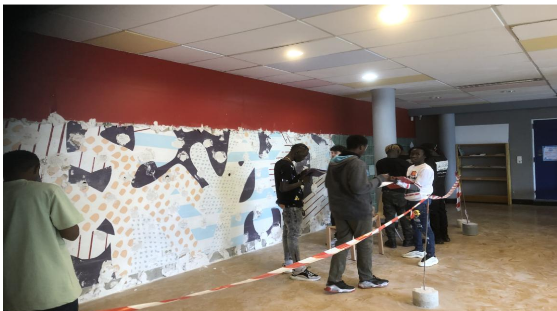
Après dépose des plaques de BA13 et du carrelage
