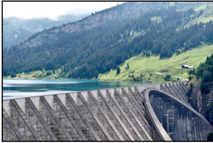
Doc. 2 Barrage hydroélectrique
