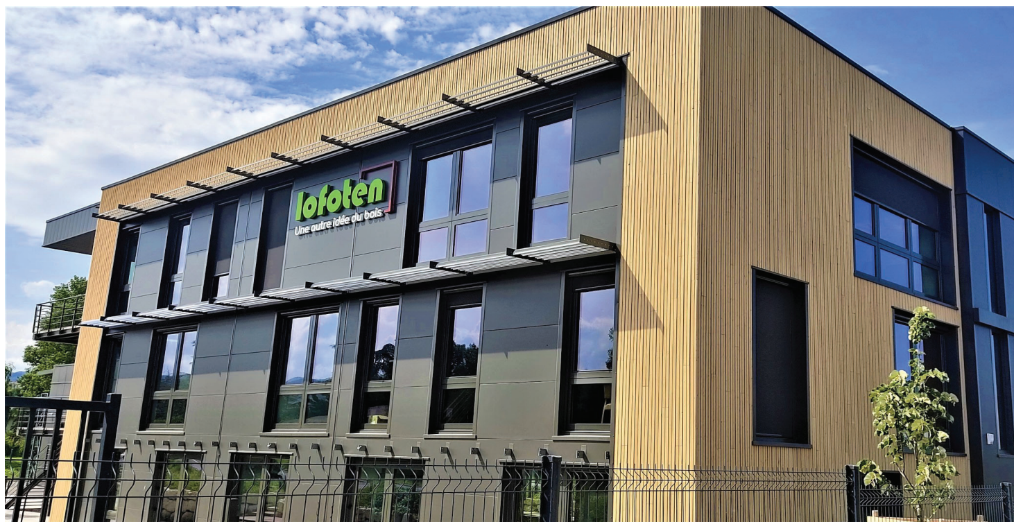
Bâtiment de l'entreprise Lofoten, situé sur la parc d'activités des Andrés à Brindas Crédit photo : Blanc Ludovic
