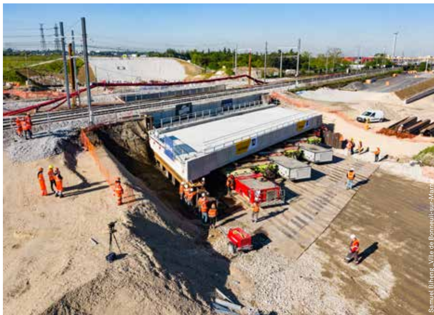
Réalisation des ponts-rails.
