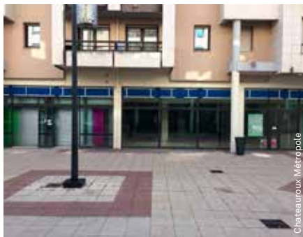
La façade de l'ancien supermarché avant l'arrivée de l'entreprise Rioland.
