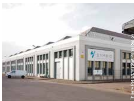
Symbio a occupé temporairement une halle de 10 000 mètres carrés au sein du site USIN.
