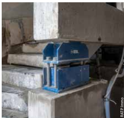
Bâtiment monté sur boîtes à ressorts.
