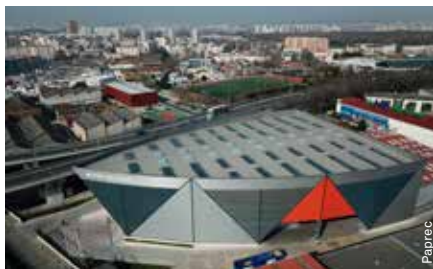
Les nouveaux locaux de l'entreprise Paprec à La Courneuve.
