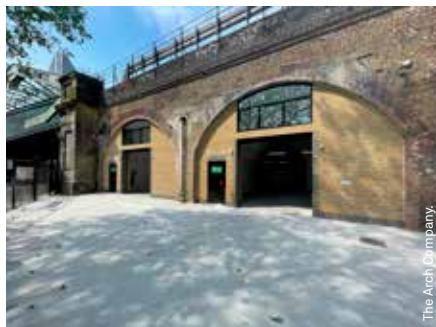
Les arches ferroviaires londoniennes à Southwark Bridge Road.
