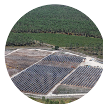
Centrale solaire au sol - Losse
