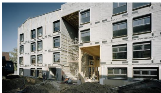
Figure 3 Foyer de travailleurs à Montreuil réalisé en modules 100% bois par Ossaboïs
