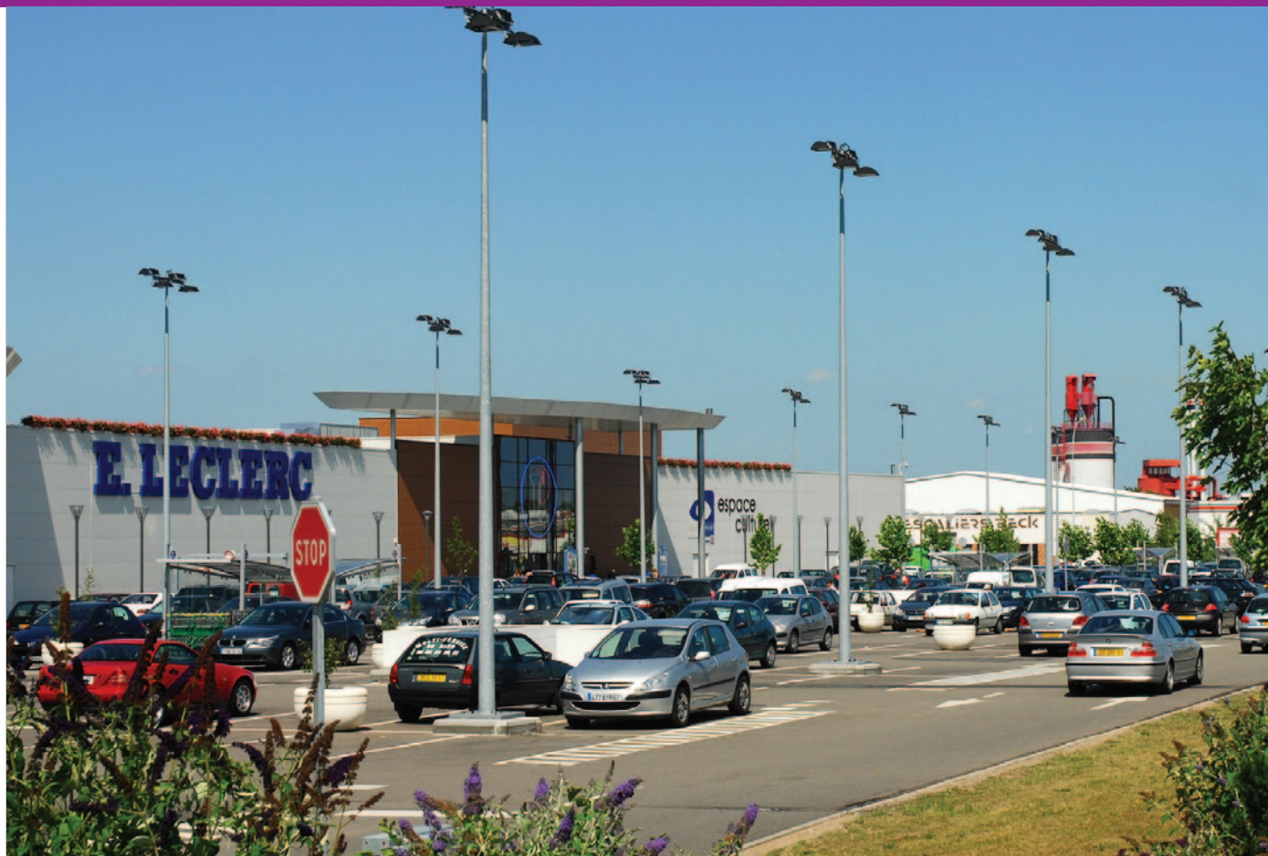
ZONE COMMERCIALE DE SÉLESTAT
