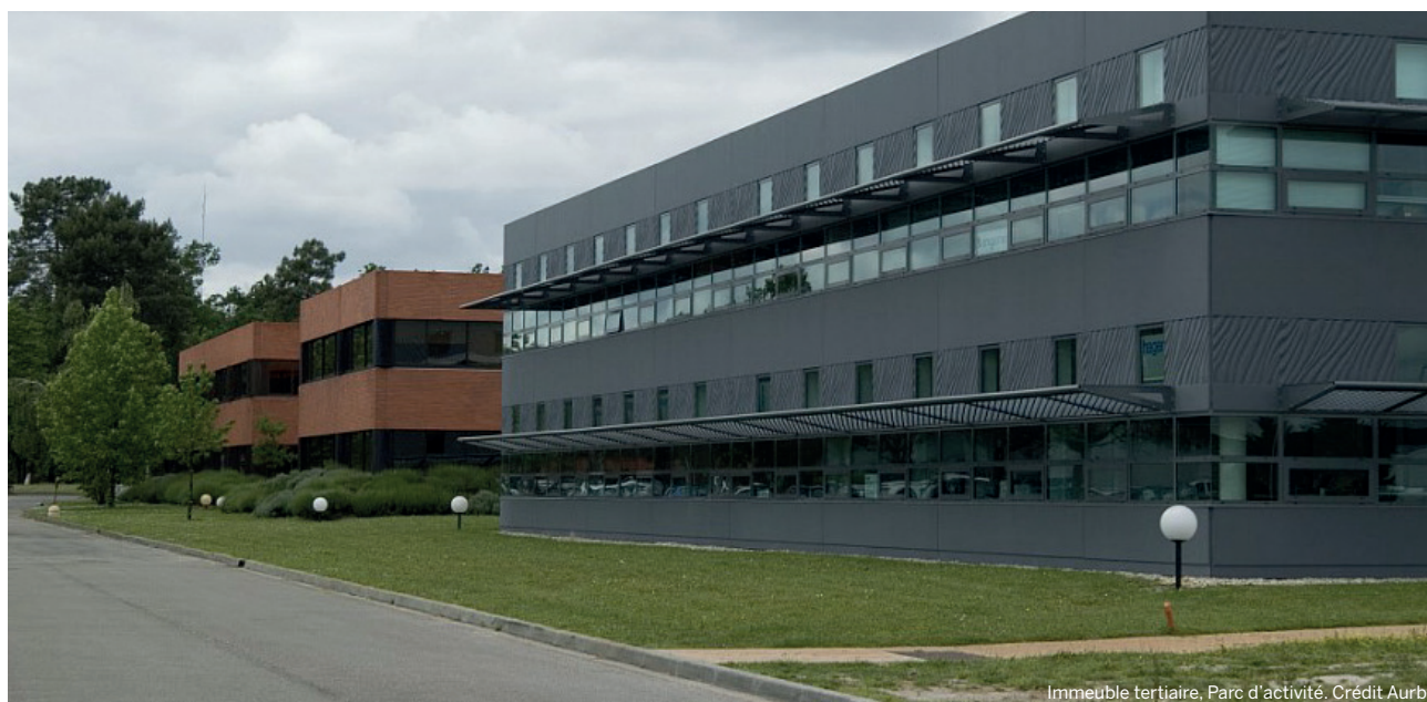
Immeuble tertiaire, Parc d'activité. Crédit Aurba
