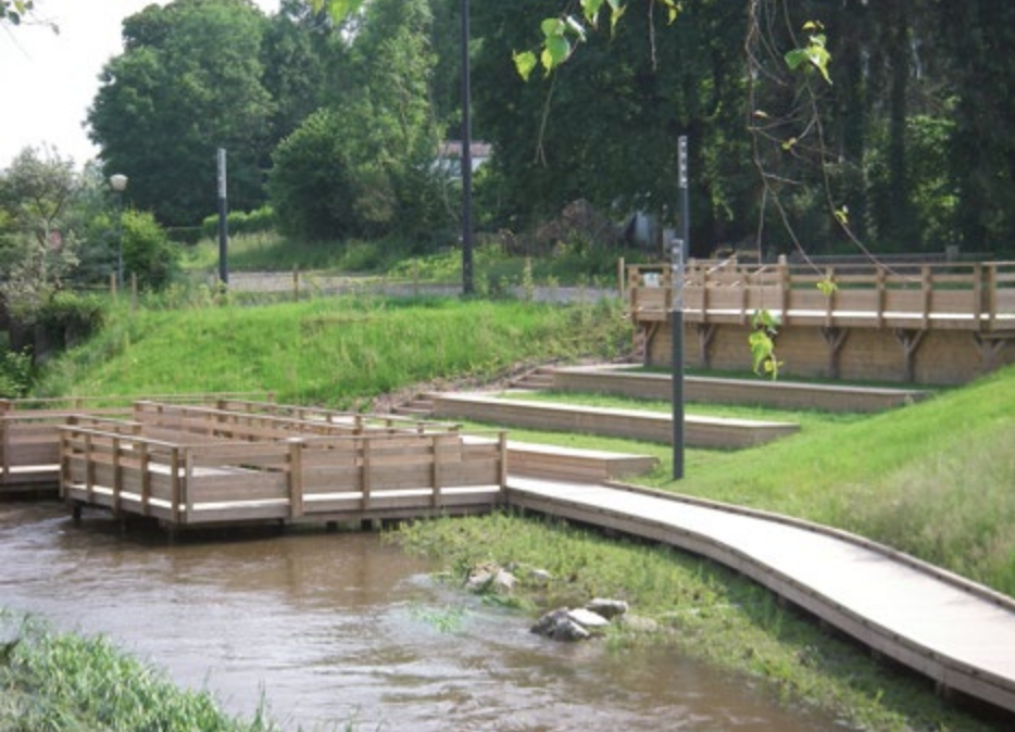
cheminement piétonnier submersible le long de la rivière. Crédit : Mairie d'Anor
