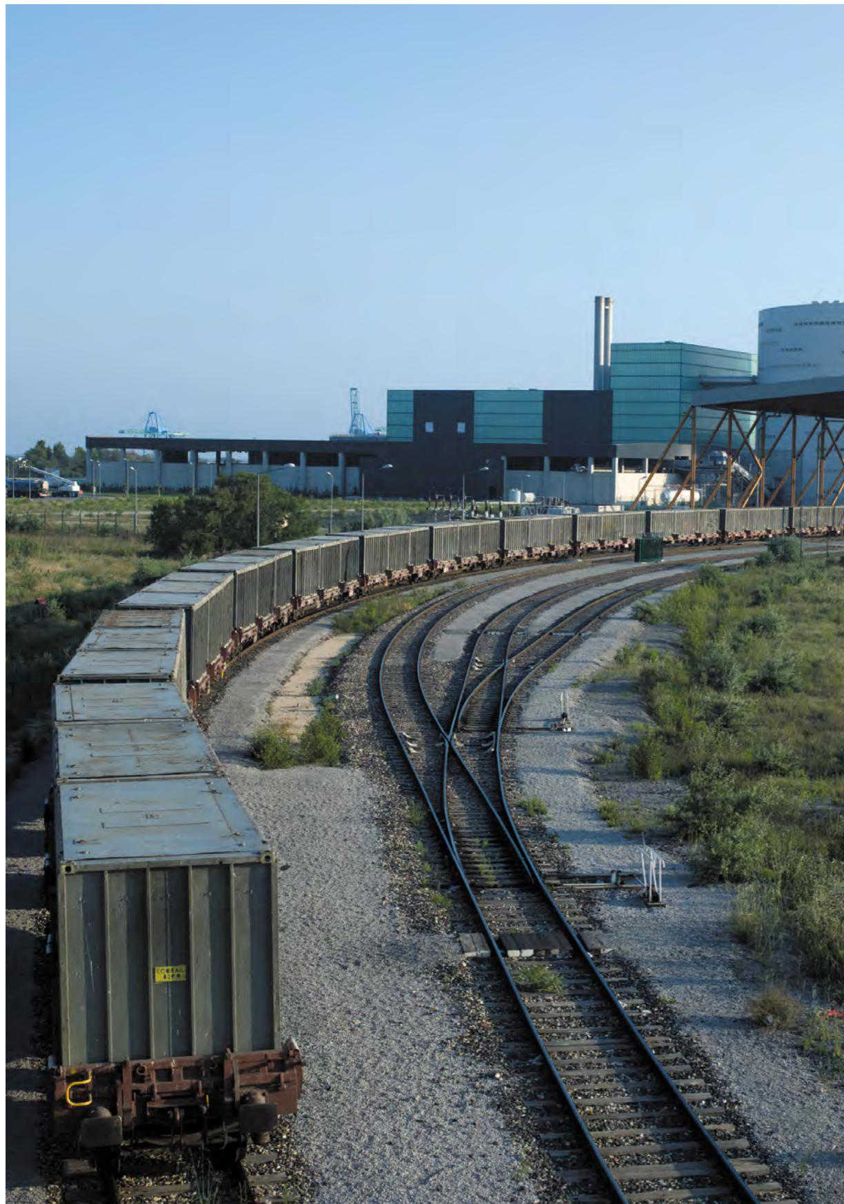
Le centre de traitement multifilières (source : EveRe).
