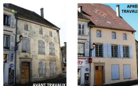
Ravalement de façade au 43, rue Diderot - Joinville Source : www.mairie-joinville.fr
