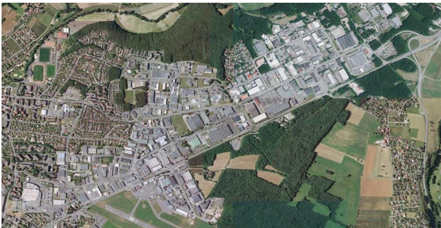
Vue aérienne de la zone d'activités du Mont à Annemasse Crédit photo : Le Messenger
