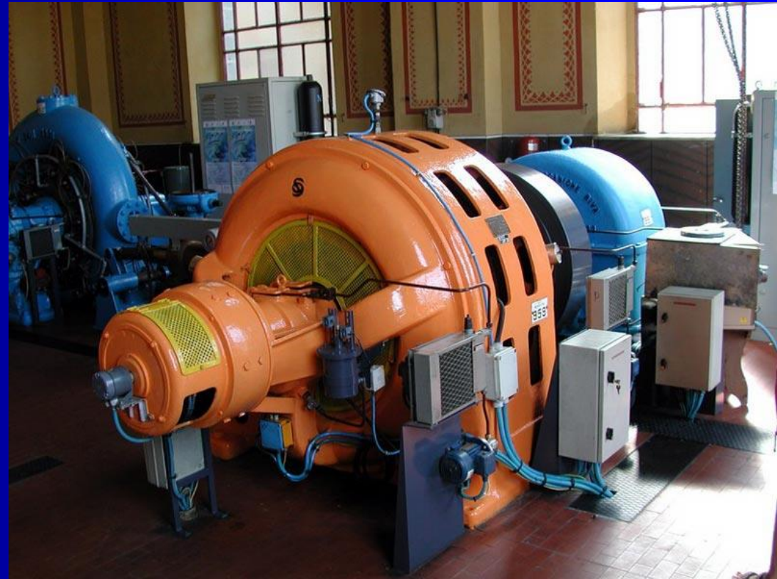
Alternatore della Centrale di Ligonchio (RE)
