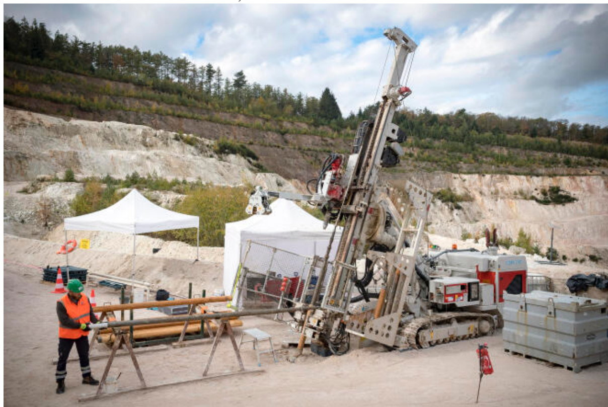
La carrière des kaolins de Beauvoir, à Echassières, dans l'Allier, le 24 octobre 2022. JÉRÔME CHABANNE POUR « LE MONDE »
