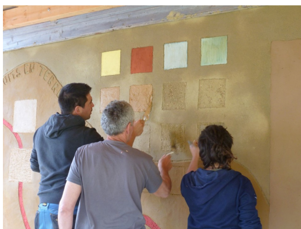
Photo : Pierre et Terre
