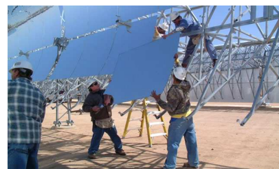
FIGURE 25.4. Andasol — une centrale solaire de « 100 MW » en construction en Espagne. L'énergie thermique en excès produite durant le jour est stockée dans des réservoirs de sels fondus pendant une durée maximum de 7 heures, permettant une fourniture stable et continue de puissance au réseau électrique. La centrale est prévue pour produire 350 GWh par an (40 MW). Les miroirs paraboliques occupent 400 hectares, et leur puissance par unité de surface sera de 10 \text{ W/m}^2 . Photo du haut : ABB. Photo du bas : IEA SolarPACES.
