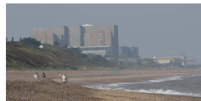
FIGURE 24.9. Centrales de Sizewell. Sizewell A, au premier plan, avait une capacité de 420 MW, et a été arrêtée fin 2006. Sizewell B, derrière, a une capacité de 1,2 GW. Photo de William Connolley.
