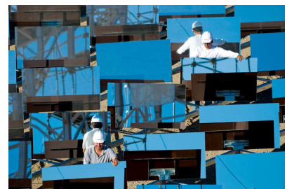
FIGURE 25.12. Deux techniciens en train d'assembler une centrale solaire à concentration eSolar utilisant des héliostats (des miroirs qui tournent et s'orientent pour suivre la course du Soleil). eSolar.com fabrique des centrales à taille intermédiaire : une unité de génération de 33 MW (crête) sur un site de 64 hectares. Cela représente 51 \text{ W/m}^2 en crête. J'en déduis donc que dans un site désertique typique, cette unité fournirait environ un quart de cette valeur : 13 \text{ W/m}^2 .
