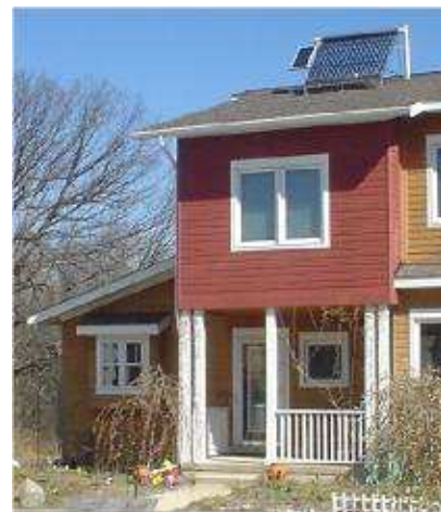
FIGURE 30.2. Un chauffe-eau solaire fournissant de l'eau chaude à une famille du Michigan. La pompe du système est alimentée par le petit panneau photovoltaïque à gauche.
