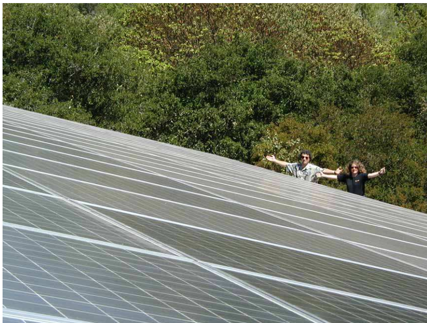
FIGURE 6.6. Deux guerriers du solaire jouissant de leur système photovoltaïque, qui alimente leurs voitures électriques et leur maison. L'ensemble des 120 panneaux (chacun fournissant 300 W et couvrant 2,2 m 2 ) couvre une surface de 268 m 2 , et délivre en sortie une puissance-crête de 30,5 kW (en tenant compte des pertes dues à la conversion du courant continu en courant alternatif) et une production moyenne — en Californie, près de Santa Cruz — de 5 kW (19 W/m 2 ). Photo aimablement fournie par Kenneth Adelman. www.solarwarrior.com
