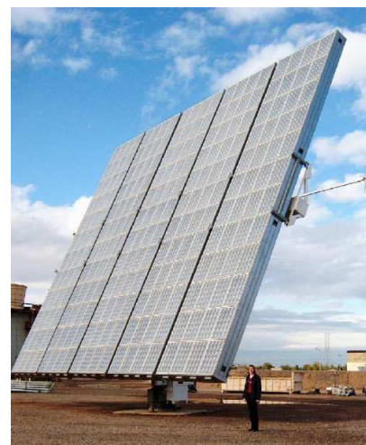
FIGURE 25.9. Un collecteur photovoltaïque à concentration de 25 kW (crête) produit par la société californienne Amonix. Son ouverture de 225 m 2 contient 5 760 lentilles de Fresnel avec une concentration optique d'un rapport 260, chacune illuminant une cellule de silicium au rendement de 25 %. Un tel collecteur, placé sur un site désertique approprié, génère 138 kWh par jour — assez pour couvrir la consommation d'énergie de la moitié d'un Américain. Remarquez l'homme en bas qui donne l'échelle. Photo de David Faiman.
