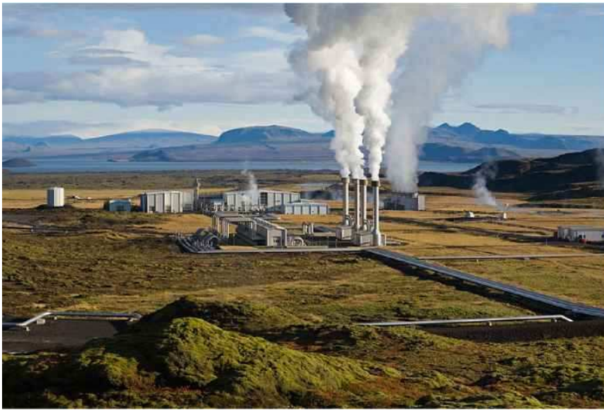
FIGURE 16.3. Puissance géothermique en Islande. La production moyenne d'électricité géothermique en Islande (300 000 habitants) en 2006 était de 300 MW (soit 24 kWh/j par personne). Plus de la moitié de l'électricité islandaise est utilisée pour la production d'aluminium. Photo par Gretar Ivarsson.
