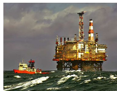
FIGURE 10.4. La plate-forme Magnus dans le secteur britannique nord de la mer du Nord, contient 71 000 tonnes d'acier. En l'an 2000, cette plate-forme a fourni 3,8 millions de tonnes de pétrole et de gaz — soit une puissance de 5 GW. La plate-forme a coûté 1,1 milliards de livres sterling (1,3 milliards d'euros). Photos par Terry Cavern.
