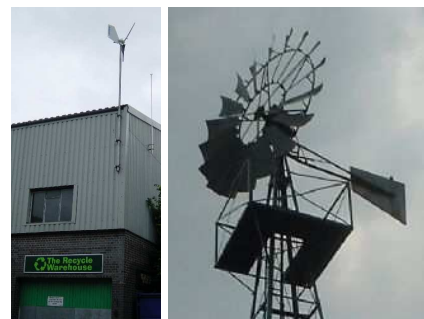
FIGURE B.9. Une micro-turbine Ampair de « 600 W ». La puissance moyenne générée par cette micro-turbine installée à Leamington Spa est de 0,037 kWh par jour (1,5 W).
