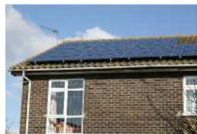
FIGURE 6.5. Le solaire photovoltaïque : les données proviennent d'un ensemble de 25 m 2 de panneaux installés dans le Cambridgeshire en 2006. La puissance-crête fournie par cet ensemble est environ 4 kW. La moyenne sur l'ensemble de l'année est de 12 kWh par jour. Ce qui fait 20 W par mètre carré de panneau.
