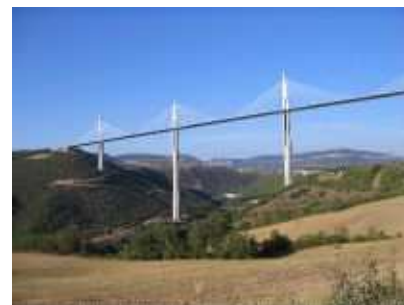
FIGURE H.7. Le viaduc de Millau, en France, le plus haut pont du monde à ce jour. Fait d'acier et de béton, long de 2,5 km et haut de 353 m.
