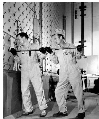
FIGURE 24.3. Des travailleurs poussant des lingots d'uranium dans un réacteur X-10 modéré au graphite.
