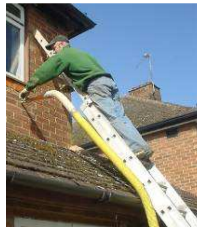
FIGURE 21.5. Insertion d'une isolation des murs creux.
