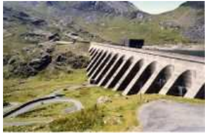
FIGURE 26.6. Llyn Stwlan, le réservoir amont de l'installation de stockage par pompage de Ffestiniog, au nord du Pays de Galles. Énergie stockée : 1,3 GWh. Photo de Adrian Pingstone.
