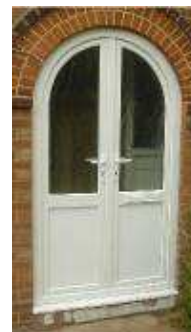
FIGURE 21.6. Une nouvelle porte d'entrée.
