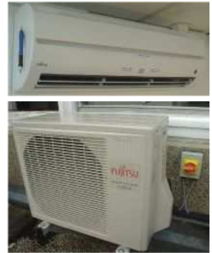
FIGURE 21.11. Les parties intérieures et extérieures d'une pompe à chaleur air-air qui a un coefficient de performance de 4. A la partie intérieure, on a joint un style à bille, pour l'échelle. Une seule de ces machines Fujitsu peut fournir 3,6 kW de chaleur en utilisant seulement 0,845 kW d'électricité. Elle peut également fonctionner de manière inversée, fournissant 2,6 kW de froid en consommant 0,655 kW d'électricité.
