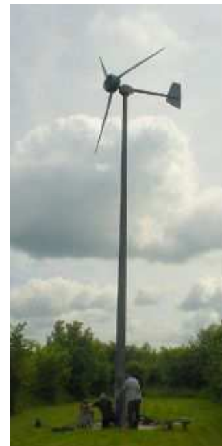
FIGURE B.10. Une turbine Iskra de 5,5 mètres de diamètre et de 5 kW de puissance [www.iskrawind.com], subissant son contrôle annuel. Cette turbine, située dans le Hertfordshire (pas vraiment la région la plus ventée de Grande-Bretagne), installée à une hauteur de 12 mètres, génère en moyenne 11 kWh par jour. Une ferme éolienne composée de machines ayant cette performance, avec une éolienne installée pour chaque carré de terrain de 30 mètres de côté, aurait une puissance par unité de surface de 0,5 W/m 2 .
