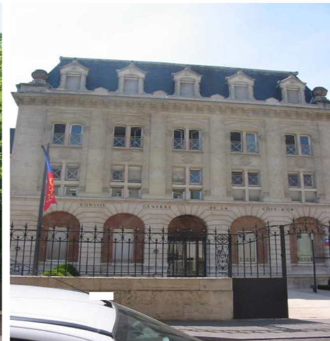
De gauche à droite École normale d'instituteurs IUFM rue Charles-Dumont - GRAHAL 2009 Groupe scolaire Trémouille boulevard de la Trémouille - GRAHAL 2005 Ancienne école normale de jeune fille rue Devosge- GRAHAL 2005
