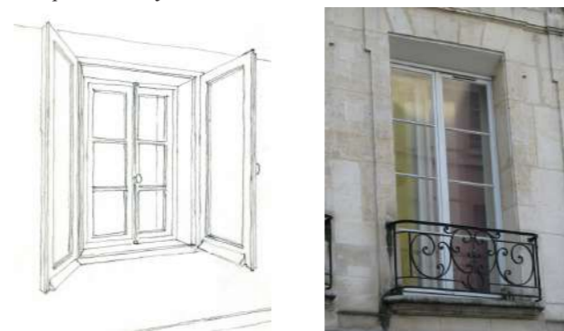
Exemple de doubles-fenêtres, vues de l'intérieur et de l'extérieur
