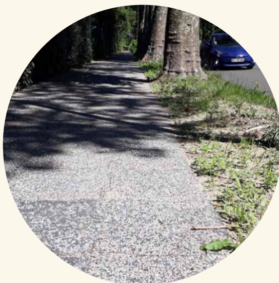
Dalles à base de plastiques recyclés : Eurovia. Revêtement perméable produit grâce à l'équivalent de 400 à 500 emballages plastiques
