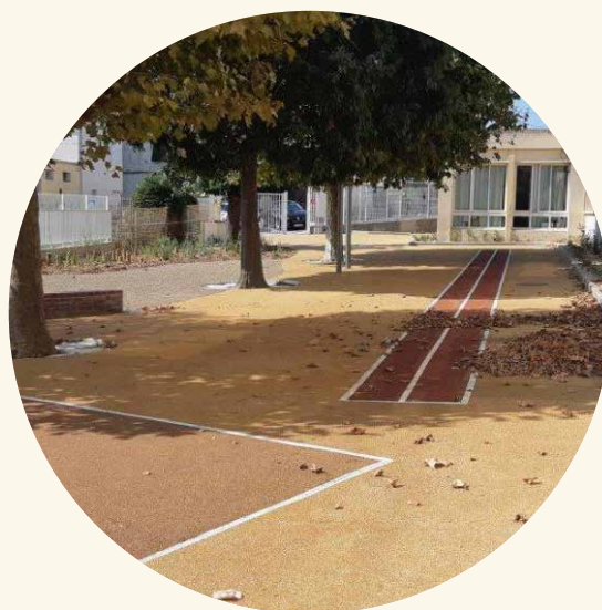
Matériaux hydrauliques : BioKlair - Eiffage. Revêtement perméable avec des liants clairs en partie issu de la filière végétale
