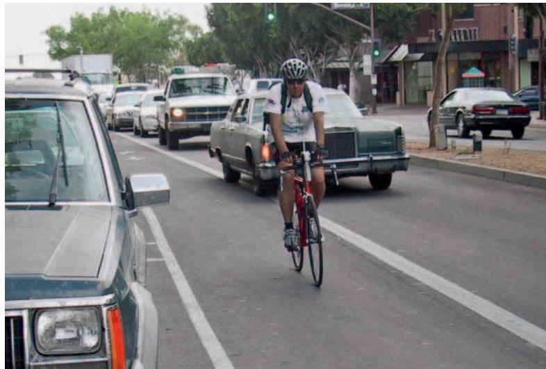
Les pistes cyclables situées entre les files de voitures stationnées et les voies de circulation n'assurent pas la sécurité des cyclistes. Elles contribuent cependant à la protection des voitures stationnées!
