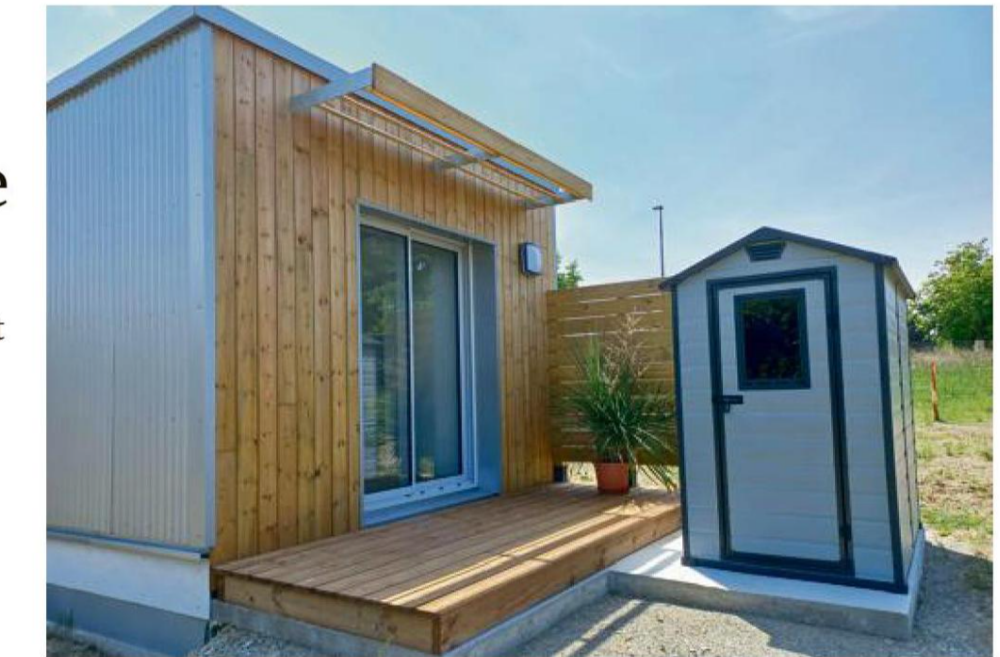
Un module préfabriqué, à Rennes, le 22 mai. RENNES VILLE ET MÉTROPOLE
