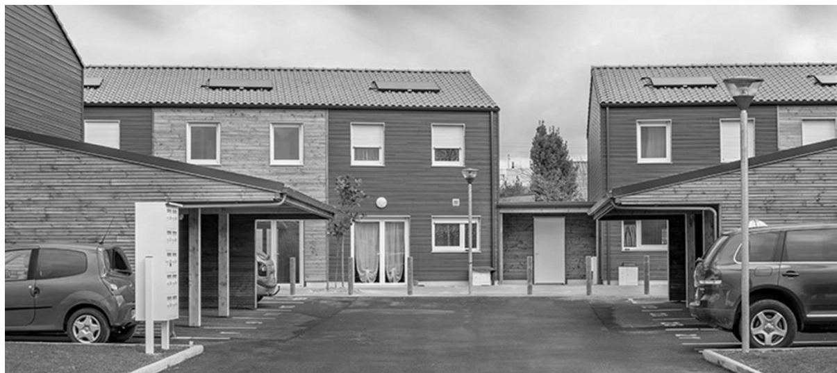
Ill. 7 : 10 maisons groupées à ossature bois aux normes RT 2012 en proche banlieue nantaise (Belenfant et Daubas, Architectes, 2013).
