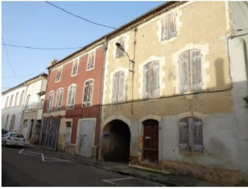
Vic-Fezensac -Ensemble immobilier vacant de grande taille dont la reconquête implique des travaux conséquents
