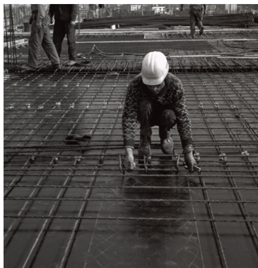
Ouvrier travaillant à la construction de la Tour Montparnasse, Gérald Bloncourt, 1971, Musée national de l'histoire de l'immigration, 2007.18.1 © EPPPD-MNHI, © Gérald Bloncourt
