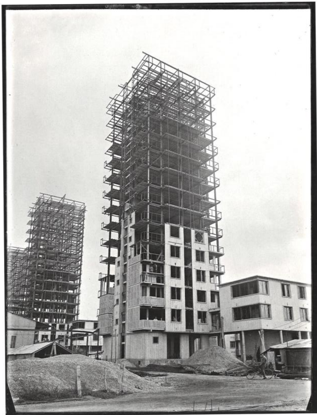
Construction d'une des tours de la Cité de la Muette, 1932-1933.
