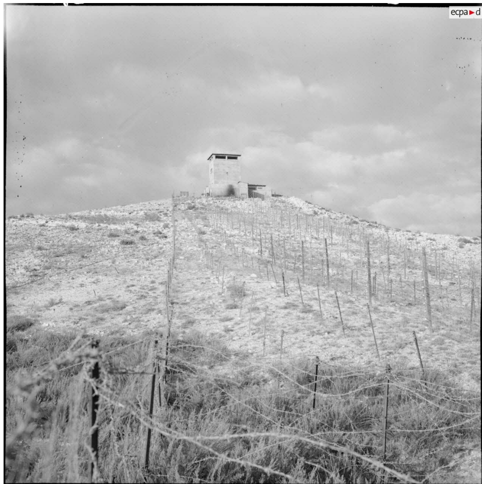
22/10/1959, El Ma el Abiod, Algérie. Poste électrique 2LP.
