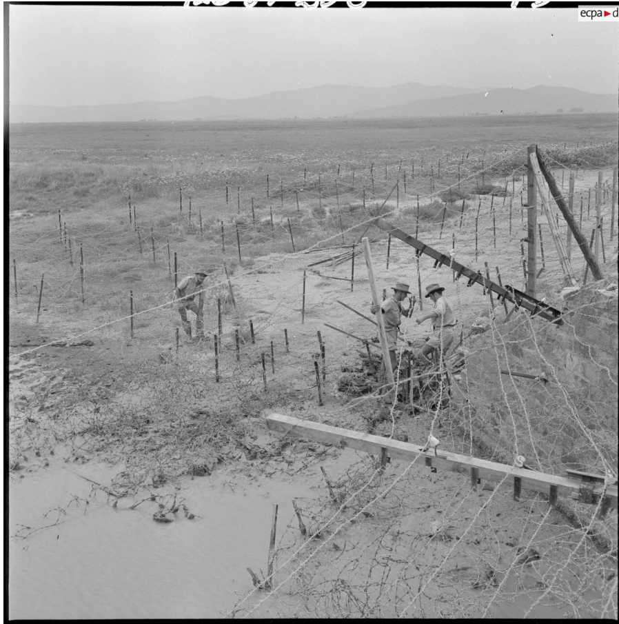
23/06/1959, Algérie. Une bande rebelle détruite aux portes de Bône. Une équipe répare le barrage endommagé par le passage de la bande. © Colin/ECPAD/Défense ALG 59-280 R13
