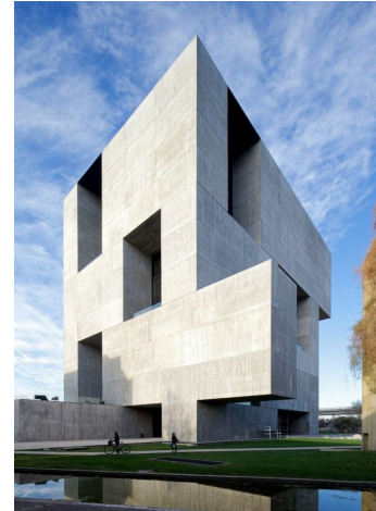
Un bâtiment public.
