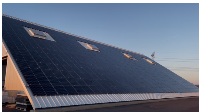
Photographie de panneaux solaires, par Alice Robert, le 2 mars 2025
