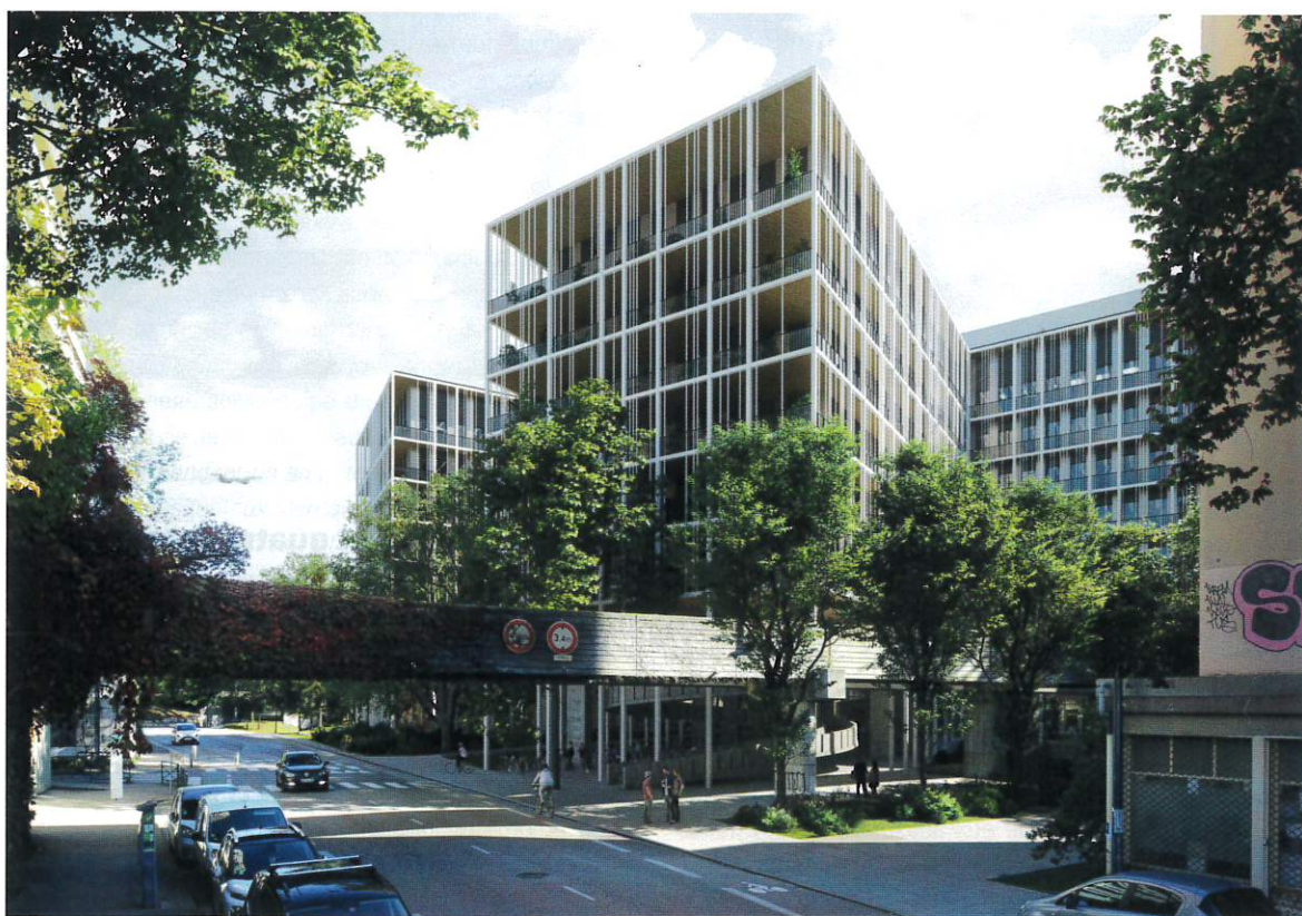
Vue depuis la rue Malakoff. © Baumschlager Eberle Architekten / Atelier A
