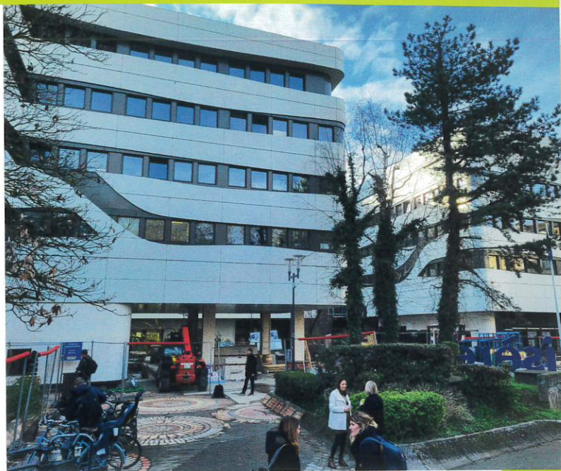
Une nouvelle façade sur 20 cm d'isolant (photo mars 2024).
