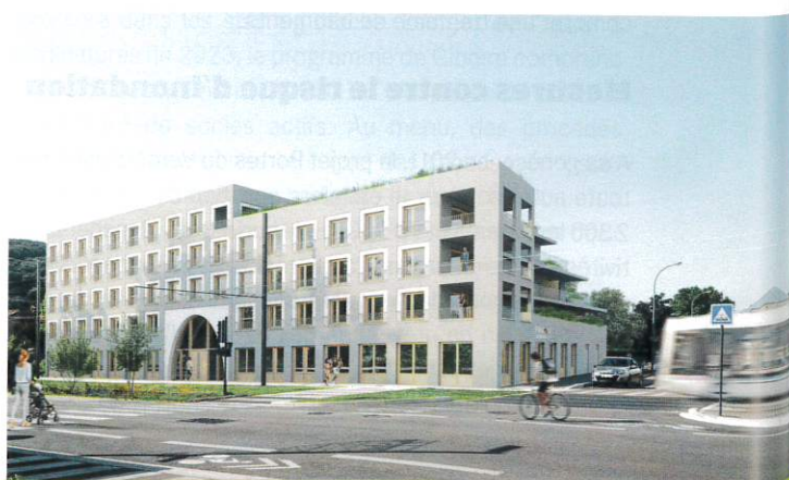
Futur pôle des services publics dans la Zac des Minotiers. © Brenas Doucerain architectes
