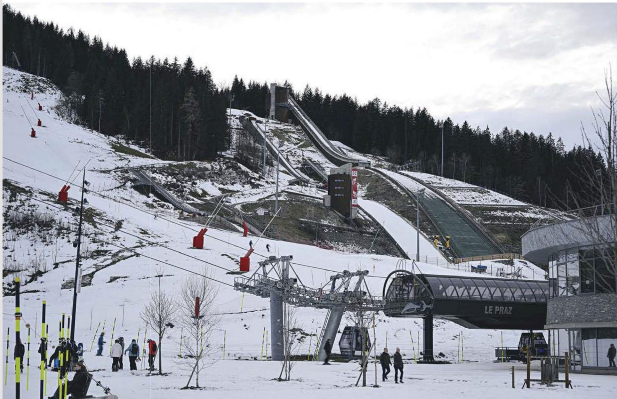
Sur le domaine des Trois Vallées, la construction du tremplin de saut à ski, à Courchevel, a entraîné un terrassement massif préalable. V. JOLY/MAGAZINE SITE OLYMPIQUE JO 2030
