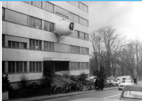
Marcel Lachat, La Bulle pirate , 1970. Polyester renforcé de fibre de verre. HLM à Genève. Idée de l'architecte Chanéac qui milite dès 1958 pour « l'implantation libre de cellules individuelles, évolutives et mobiles » contre l'excès de rationalisme causé par l'explosion démographique dans années 1960.
