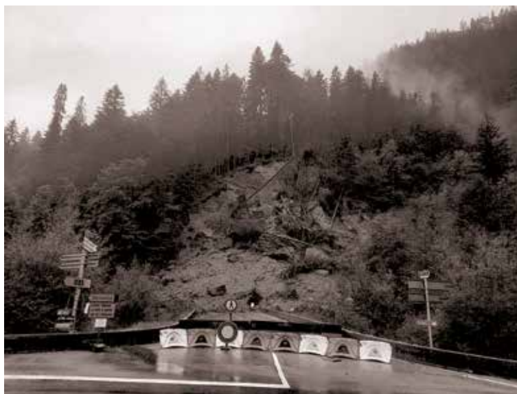
Une route ayant subi des glissements de terrain peu avant Morzine vers le col de l'Encrenaz, septembre 2024.
