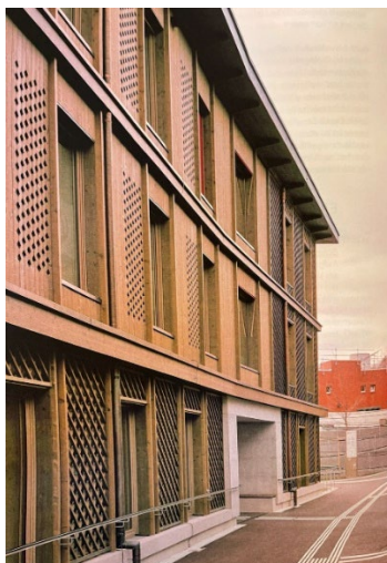
Figure 28 : Traçage bandes blanches au sol et structure du bâtiment invitant à la découverte tactile
