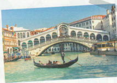
Ponte di Rialto
