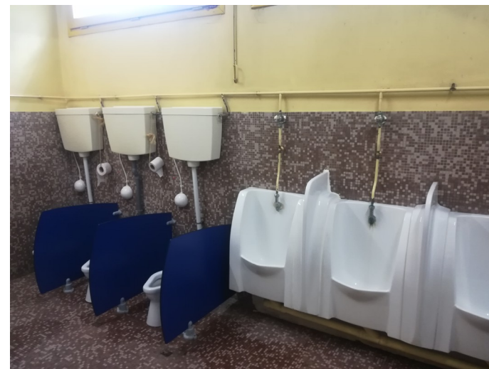
La salle d'eaux
