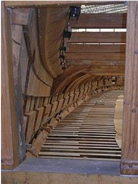
Reconstruction de la frégate Hermione à Rochefort en bois massif.
