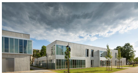
Centre social Georges Brassens - Creil (oise) Nomade Architecte - 2015
