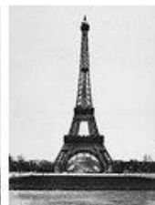
Fin mars 1889 : vue générale de l'ouvrage achevé
