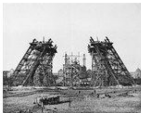
7 décembre 1887 : montage de la partie inférieure sur les pylones en charpente
