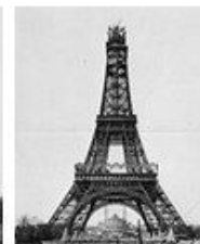
26 décembre 1888 : montage de la partie supérieure
