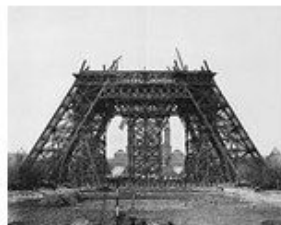
20 mars 1888 : montage des poutres horizontales sur l'échafaudage du milieu
