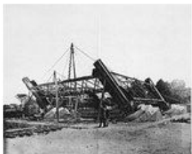
18 juillet 1887 : commencement du montage métallique de la pile n° 4
