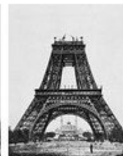
21 août 1888 : montage de la deuxième plateforme
