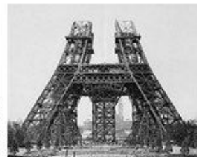
15 mai 1888 : montage des piliers au-dessus du premier étage
