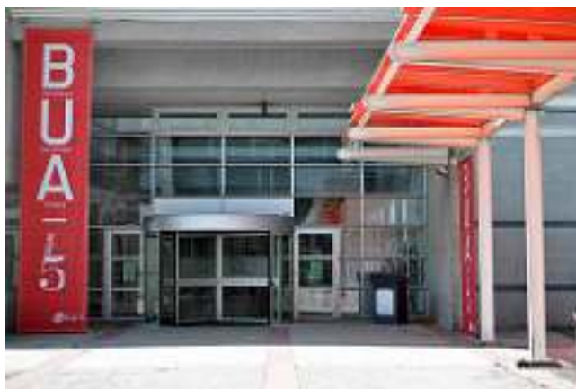
Figure 3.2 Une adaptation en France, à la bibliothèque Belle Beille de l'université d'Angers, exploite la division du bâtiment en trois blocs et une signalétique colorée sur les poteaux porteurs du bâtiment.
