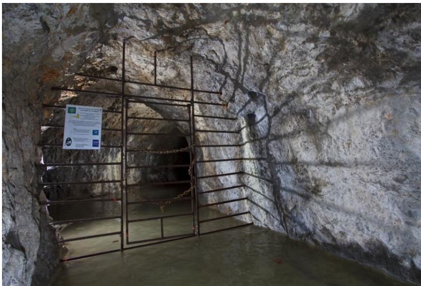
Pose de grilles
