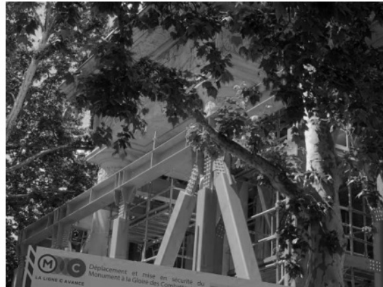
4- Une structure orange en métal autour d'un monument
