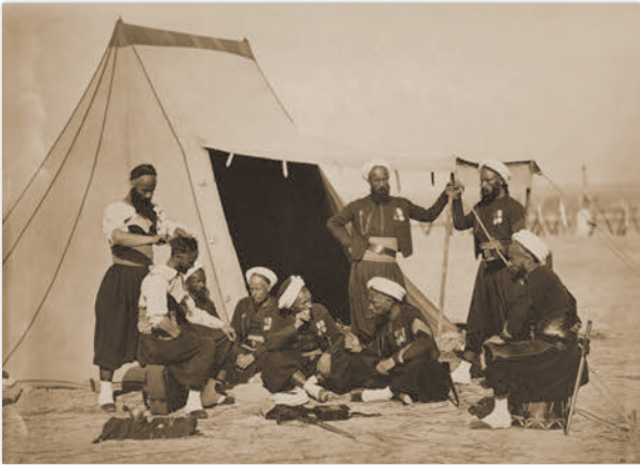
Toilette des zouaves [Camp de Châlons], épreuve sur papier albuminé, photographie de Gustave Le Gray, 1857.
